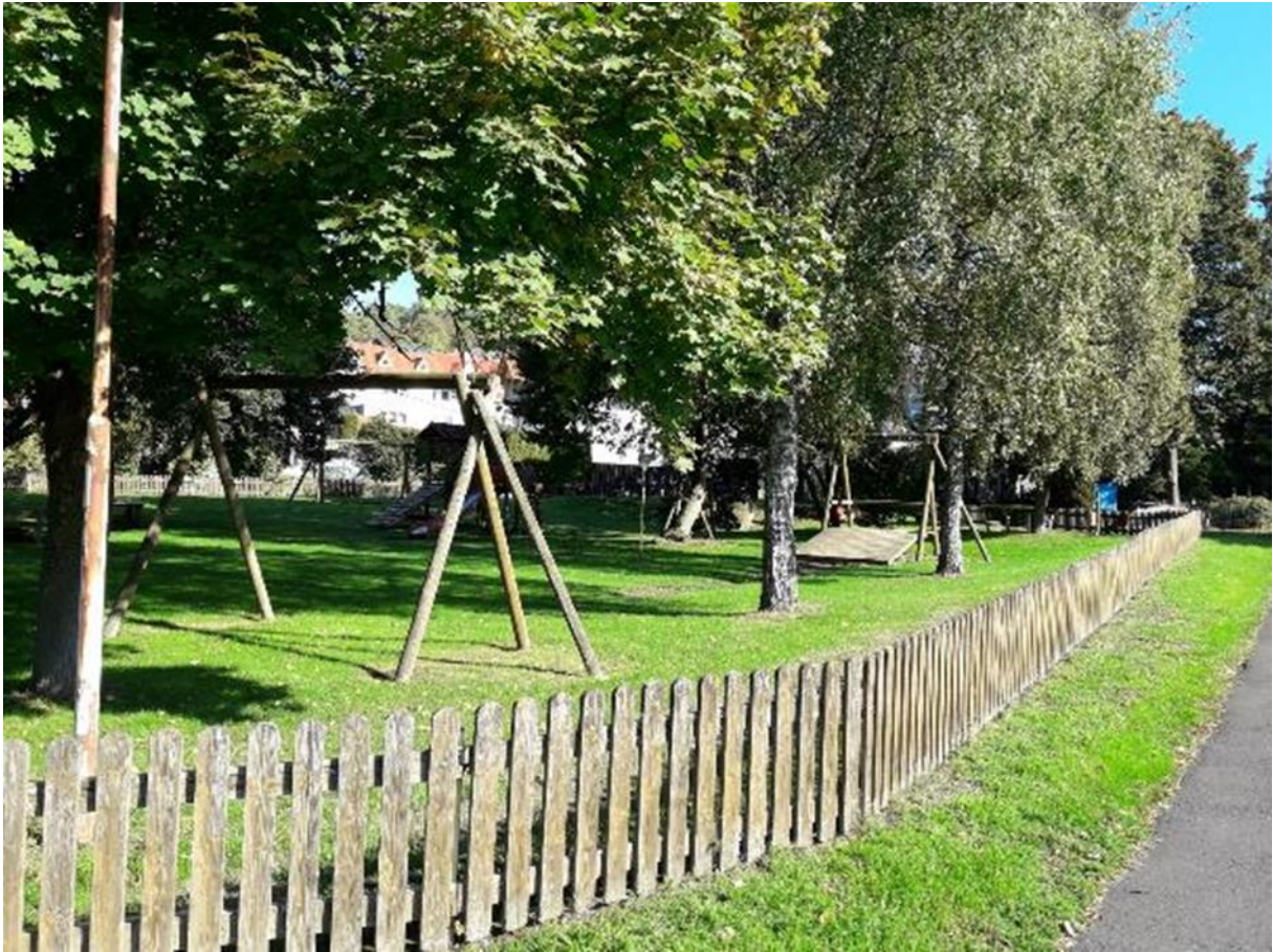
Abb. 16: Potentialfläche für die Freilegung des Bachlaufs am Spielplatz in Weißenborn. Die Verrohrung der Weißenborn verläuft ungefähr unter dem Zaun des Spielplatzes. Eine Öffnung würde sowohl aquatische Habitate und die Durchgängigkeit wiederherstellen als auch Ortsbild und Aufenthaltsqualität verbessern.
