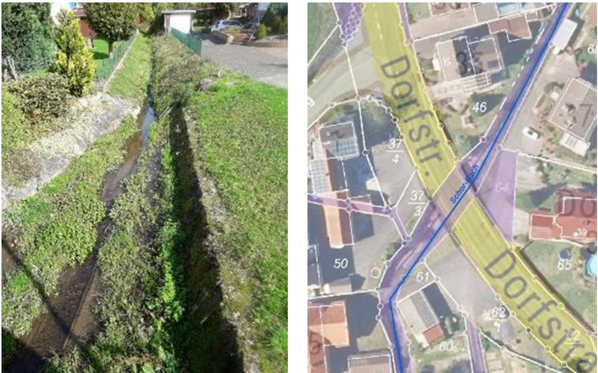
Abb. 17: Potentialfläche für die Schaffung natürlicherer Ufer- und Sohlstrukturen bei gleichzeitiger Verschönerung des Ortsbildes am südlichen Ortseingang von Schorbach (Flurstück 64). Links: Blick von der Brücke der Dorfstraße stromaufwärts Richtung Nordosten. Rechts: Lageplan mit kommunalen Flurstücken in lila.
