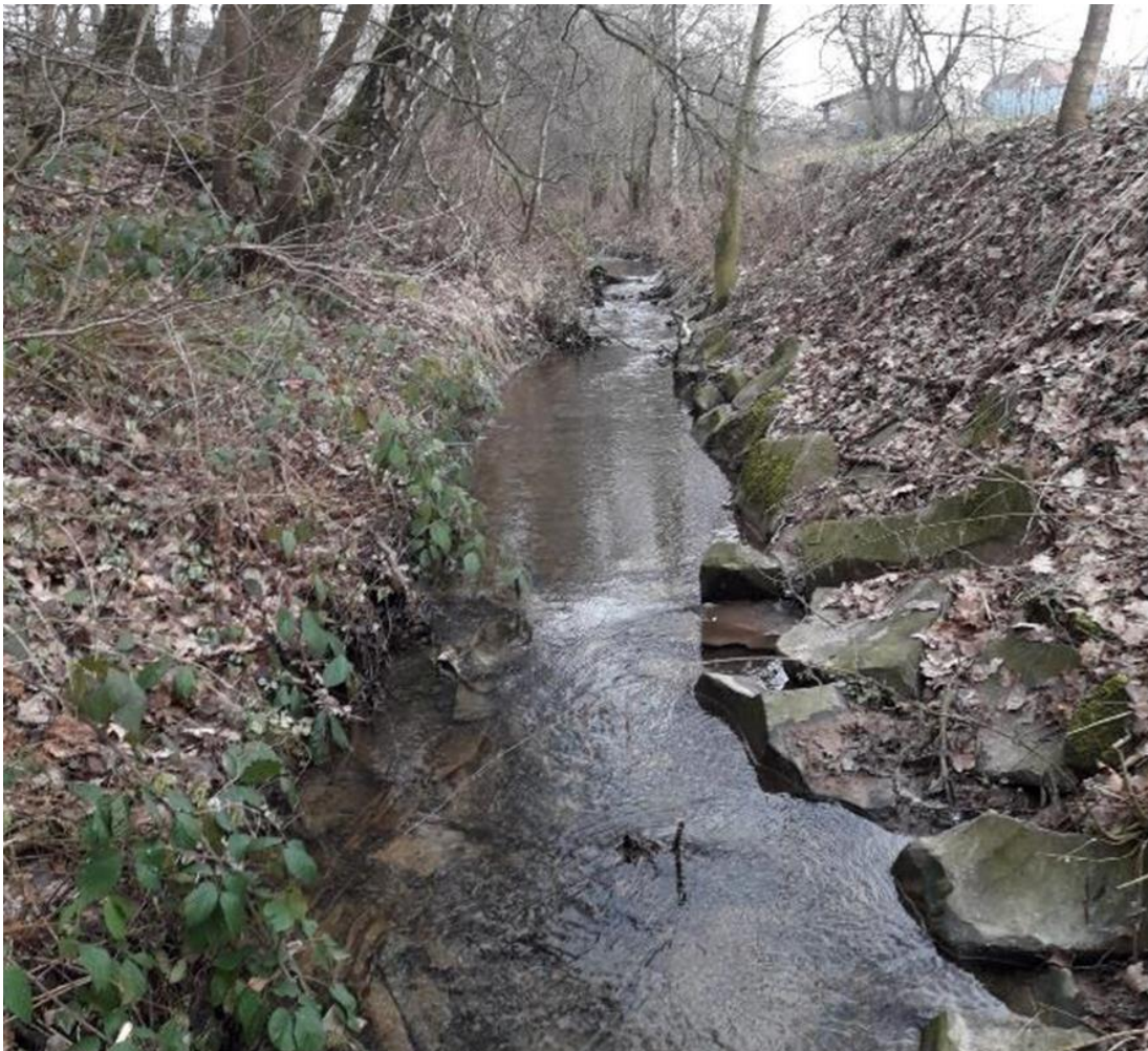
Abb. 14: Otter am Freizeitgelände in Ottrau. Der Lauf ist stark eingetieft und eingeeengt, es sind Reste einer massiven Uferbefestigung vorhanden. Etwas stromaufwärts, entlang des Bauhofes befindet sich auch viel Unrat im und am Gewässer. Die Grundstücke auf beiden Seiten gehören der Gemeinde, am linken Ufer (im Bild rechts) wäre Platz für eine Uferabflachung und Laufaufweitung.
